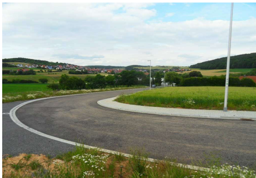
Blick nach Nord-Ost - Richtung Greußenheim
